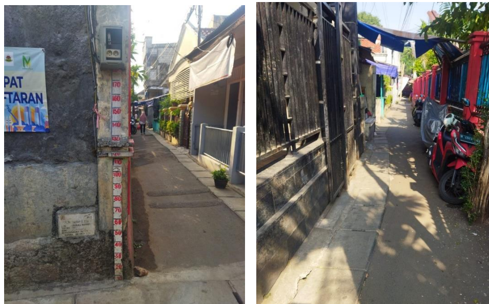
Gambar 3. Pembuatan pengukur debit air dan pembuatan selokan-selokan baru
